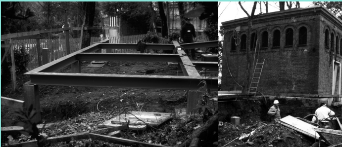
건설 중인 한국관 The Korean Pavilion under construction, 1995
